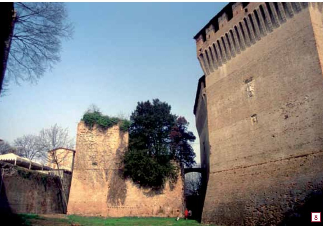
Fig. 8: Rivellini. Montechiarugolo (PR). Nel castello, dovuto al condottiere visconteo Guido Torelli nel secondo decennio del Quattrocento, si trovano due imponenti rivellini, le cui precipua funzione riteniamo fosse di impedire l'attraversamento del fossato tramite due batterie laterali di tre bombardiere ciascuna. La disposizione sarebbe stata assai più efficace se si fossero disposte le artiglierie anche alla base dei rivellini, come nel castello sforzesco di Milano, ma per l'inizio del Quattrocento sarebbe stato una anticipazione impensabile.
