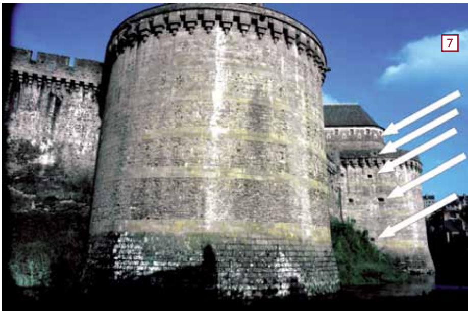
Fig. 7: Distribuzione altimetrica delle bombardiere. Fougères (Ille et Villaine, F). Un importante metro di giudizio sulla modernità delle rocche quattrocentesche è costituito dalla quota delle bombardiere casamattate. Nelle rocche della Transizione, infatti, una delle più evidenti novità è costituita dall'uso sistematico delle bombardiere a tiro radente sul terreno circostante e dall'apparizione delle bombardiere a quota del fondo del fossato, che restavano invisibili e quindi inattaccabili dall'assediate finché questi non fosse giunto ad attestarsi sul ciglio di controscarpa. Nei torrioni di Fougères, molto tardi, le quote si moltiplicano.
