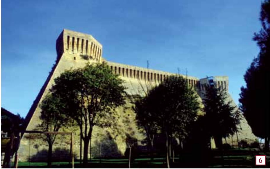
Fig. 7: Acquaviva Picena (AP). La rocca è ristrutturata da Baccio Pontelli nel 1488. Il grande progettista terrapiena per un'altezza di molti metri, con imponenti movimenti di terra, un più antico castello e gli addossa una enorme scarpa riportata nel cui spessore ricava due gallerie che conducono ad altrettante pusterle e ad una nutrita serie di bombardiere. Particolarissimo l'innalzamento della scarpa fino allo spicco dei beccatelli, soluzione mai utilizzata da Baccio Pontelli in altre fortificazioni e rarissima in assoluto.
